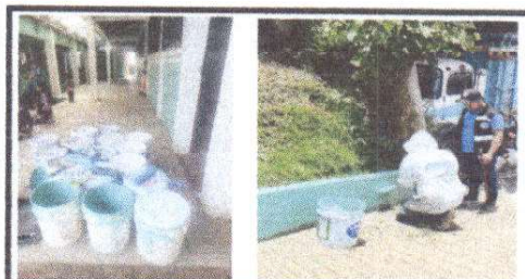
Foto 2: Sustitución de de pintura en muros, interiores y exteriores.
