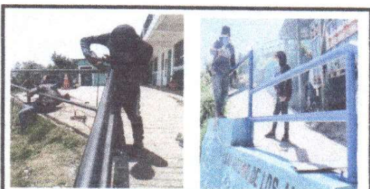
Foto 3: Mejoramiento de barandas
