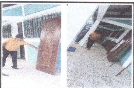
Foto 5: Sustitución de puertas
