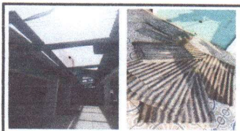
Foto 4: Sustitución de cubierta de lámina
