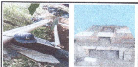
Foto1: Mejoramiento de drenaje y cocina escolar.
